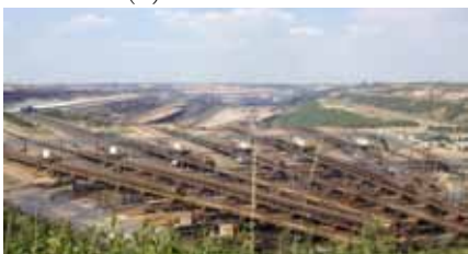
Hier kommen alle Förderbänder zusammen. Kohle geht ans Kraftwerk, Abraum zurück in die Grube.
